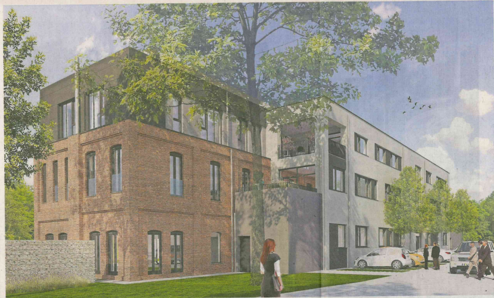
Die alte Fassade bleibt – ergänzt um einen schlanken Anbau – erhalten. Dahinter entsteht ein neues Haus.
